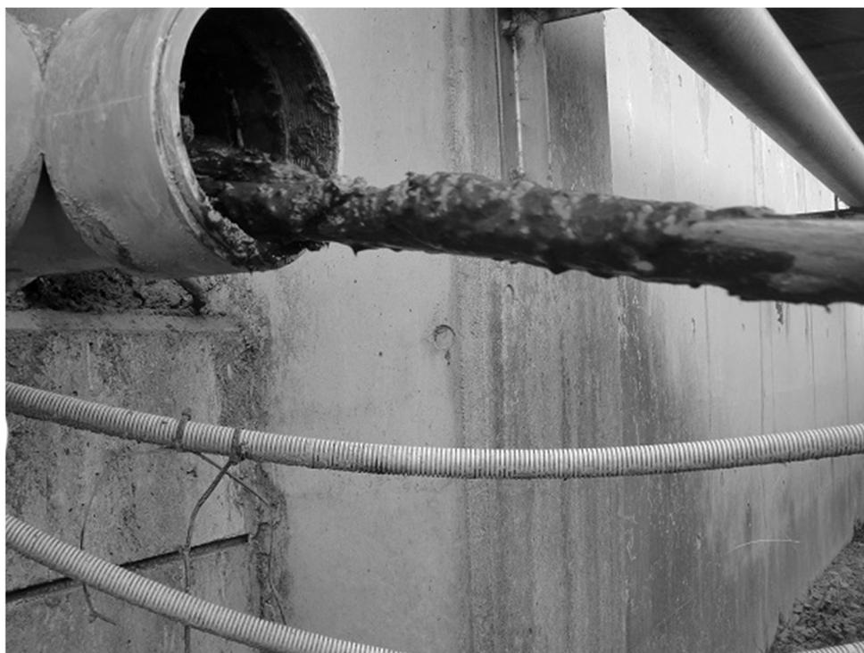
図3 排気配管経路内に設置したステンレスメッシュ製の簡易除塵フィルターに付着した泥濁化した堆肥粉塵
