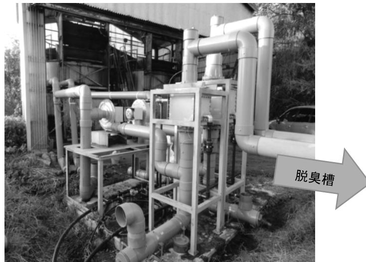
図 7 熱交換器設置の様子
