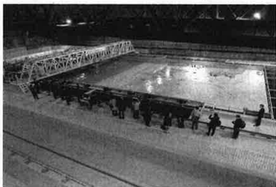
写真-5 沿岸域減災実験施設 (全景)
