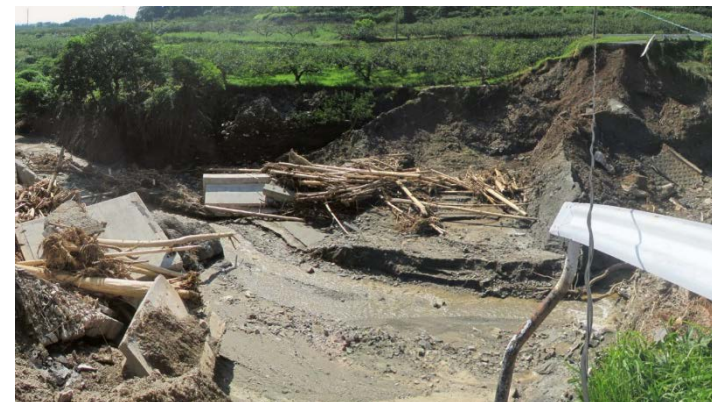
九州北部豪雨(山の神ため池)
