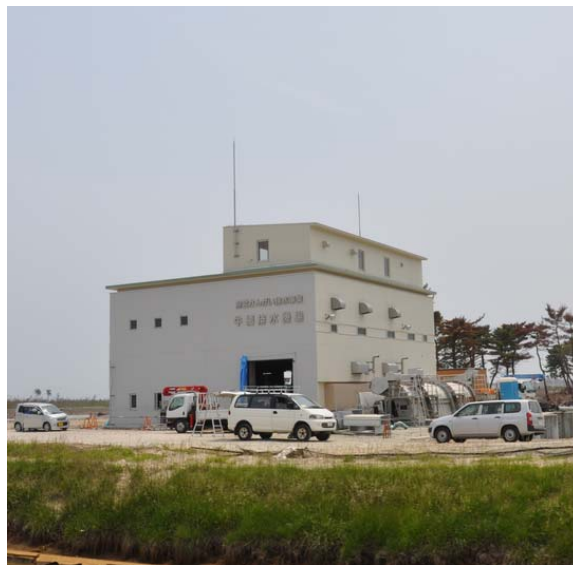
写真2 新牛橋排水機場 アンテナのつついている3階部分に周辺の住民が避難した。津波は2階まで達した。
