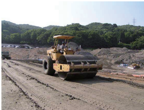
写真 7.7 振動ローラによる解砕土の転圧状況
