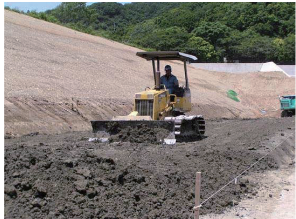
写真 7.6 ブルドーザによる解砕土の敷均し状況
