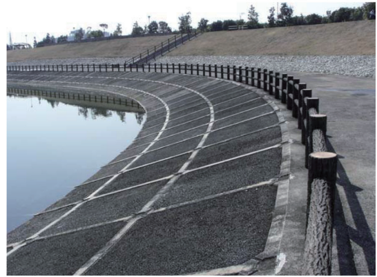
写真 3.2 法枠透水ブロック張の例
