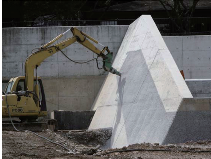
写真 7.8 はつり機（スパイクハンマー）によるチッピング状況
