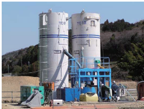
写真7.1 設置された固化材スラリープラントの例
