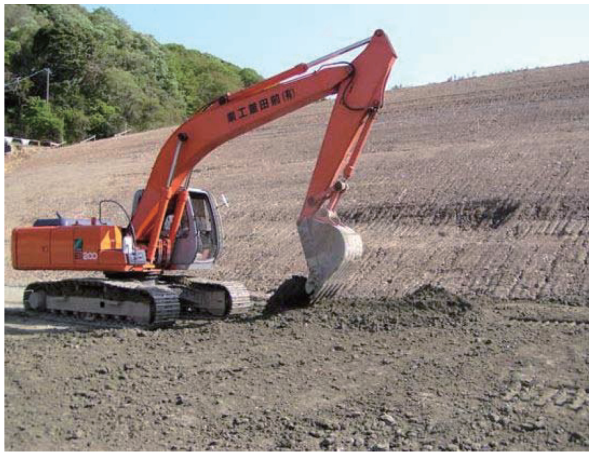
写真 7.5 バックホウによる解砕土の撒出し状況
