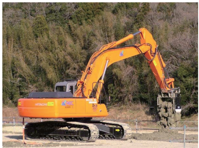
写真 7.2 トレンチャー式攪拌混合機による初期固化状況の例 (ベースマシンは 1.4 m 3 級 BH で改良深さ 2.5 m)
