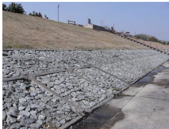
写真 3.3 法枠栗石詰の例
