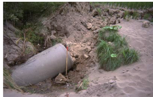
図 6.3 地震によって浮上したパイプ
