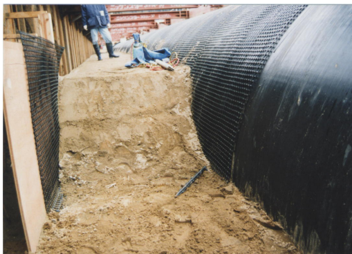
施工事例（ソイルセメントによる埋戻し中，施工幅 100cm）
