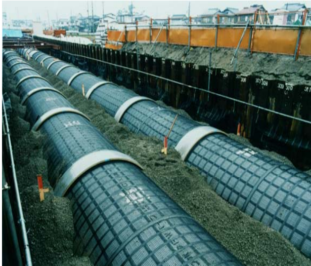
浅埋設工法による大口径パイプの施工
