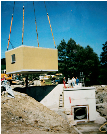
Fig.4 建設中の発電所の概要 Outline of hydropower plant under construction
