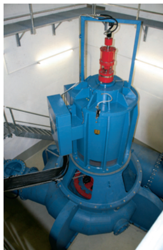
Fig.3 カプラン水車 Kaplan turbine at Main-Donau canal
