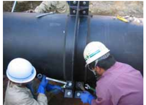
止水壁の設置
