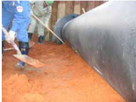
図-4.2.5 管底部の突固め状況
