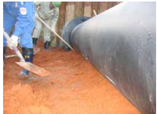
管底部への基礎材投入・締固め
