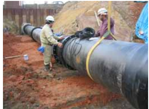
底樋管の接合
