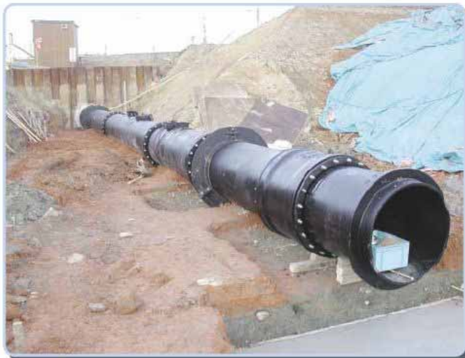
柔構造底樋(上流側)
