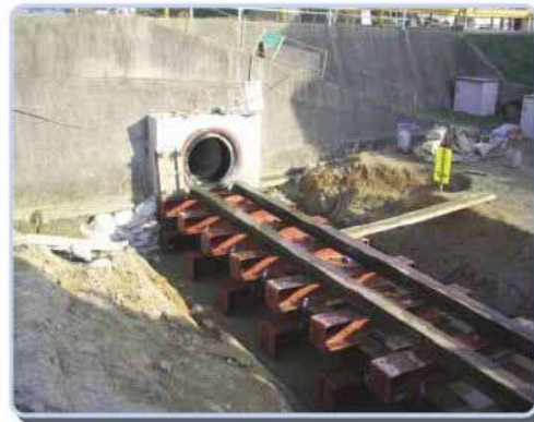
推進工法部分(下流側)
