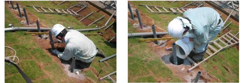
④ 鉛直ドレーン周りのフィルター(砂礫材)投入
