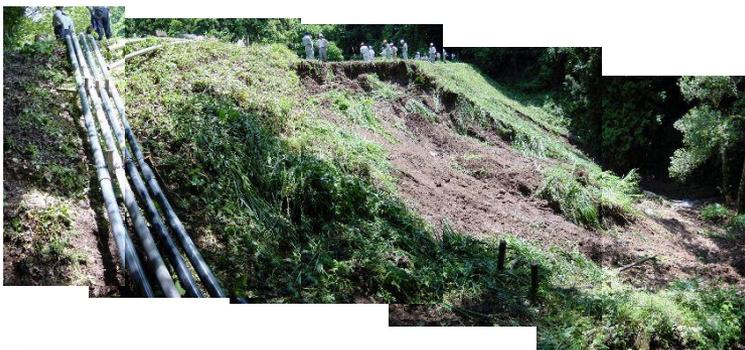
2002年の微雨前線豪雨によってすべり破壊した銭茂谷内下ため池
