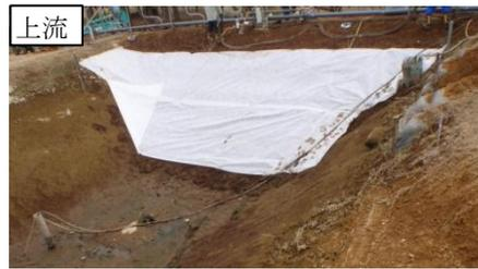
① 堤体表面の整形・吸い出し防止シートの敷設
