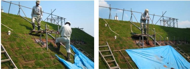
① 足場の設置・鉛直ドレーン孔の掘削
