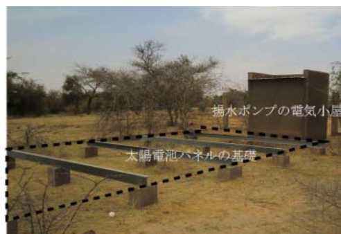
写真 3 太陽電池パネルのないポンプ小屋
