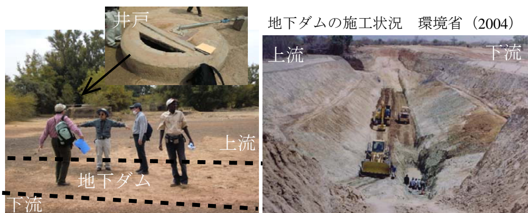
写真 2 地下ダム上部の状況と地下ダム施工時の風景
