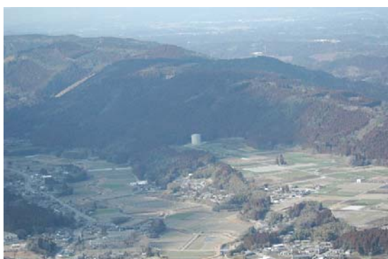
写真6 ファームポンドの遠景
