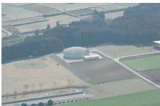
写真8 ファームポンドの遠景
