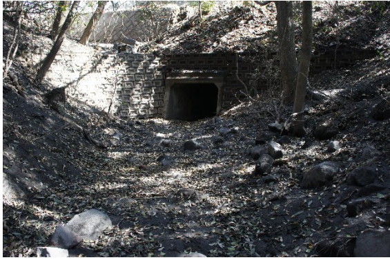
写真 19 沢を横断する道路の暗渠
