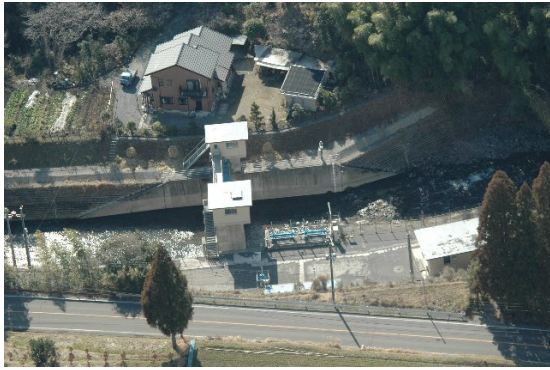
写真 10 田野頭首工の状況
