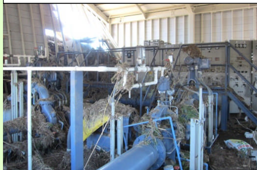
末端の揚水機場の内部の被災状況
