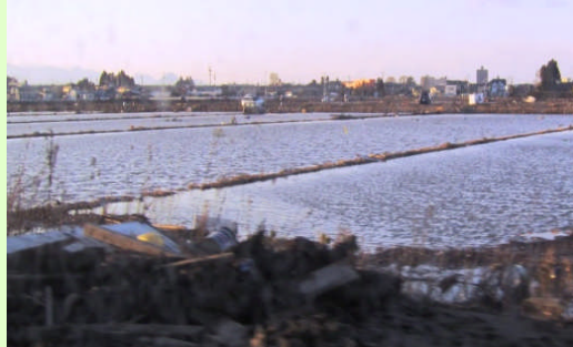
瓦礫に覆われた排水路。降雨時の通水阻害が懸念される。
