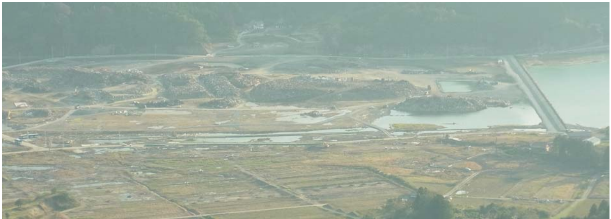
▲右端が仮設の海岸堤防 農地にガレキを集積、湛水状態が続く
