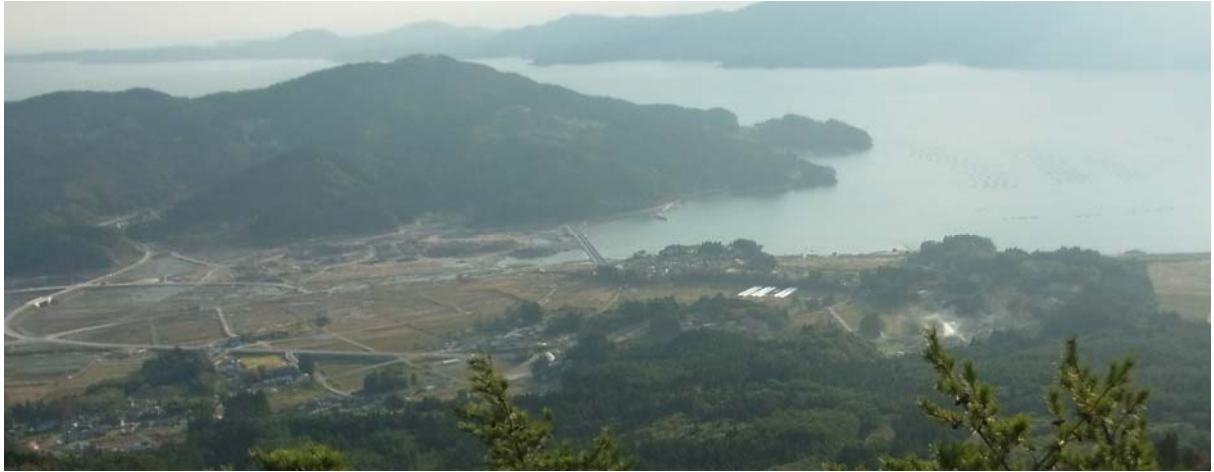
▲右端から養殖筏、決壊した堤防の跡、仮設堤防、湛水した農地へと続く
