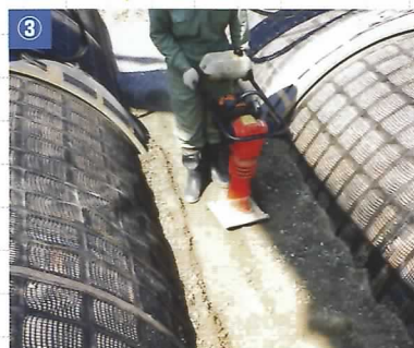
碎石の撒き出し、転圧
