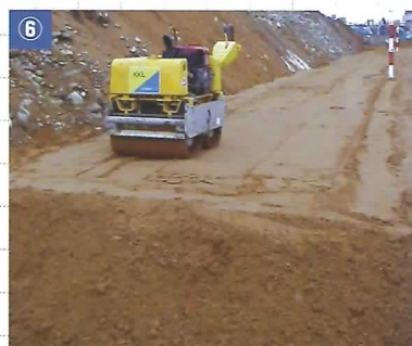
管上部の埋戻し、転圧
