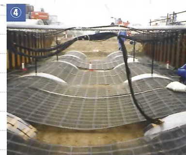
ジオテキスタイルの敷設
