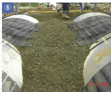
砕石の撒き出し、転圧
