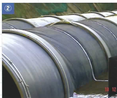
ジオテキスタイルの敷設
