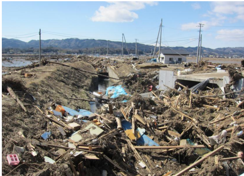
▲ ガレキに覆われた農業排水路（3月18日）
