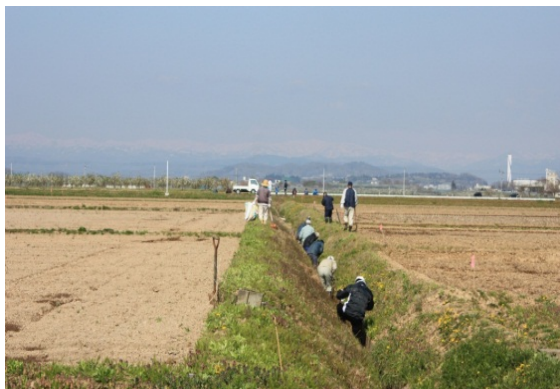
・「堰払い」において、水路(土水路)の泥上げを行っている状況。
