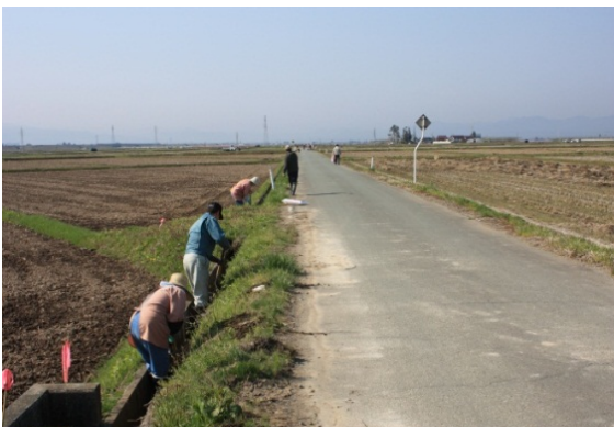
・「堰払い」において、水路(U字溝)の泥上げを行っている状況。
