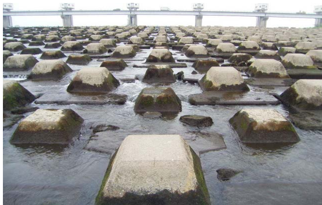
写真-8 下流護床工
