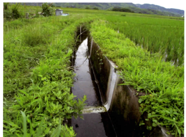
写真3 施工後の状況 （2008年11月に補修したもので、2009年6月においても良好な状態でした）
