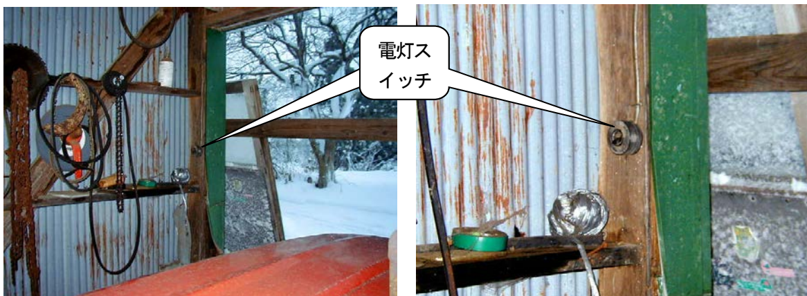
移設した電灯スイッチ
