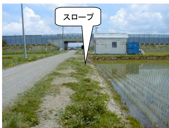
対策済み圃場（排水路側）
