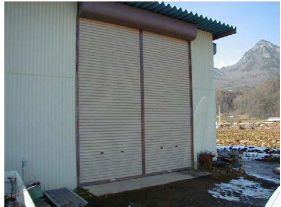
作目：共通 作業：圃場・施設管理 目的：施設整備 方法：作業場の出入口を敷居がなく、広い間口にした。
