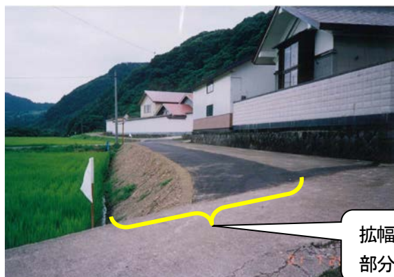
工事後の状況
