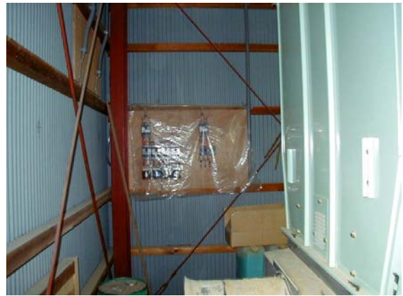
作目：共通 作業：圃場・施設管理 目的：作業安全、施設整備 方法：漏電や火事を防止するため、スイッチ等へカバーを掛けホコリが溜まるのを防止する。
