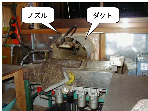
取り付けたダクト
