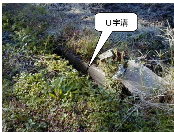
設置したU字溝
