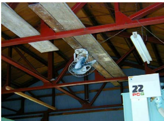
作目：共通 作業：圃場・施設管理 目的：温度調節 方法：扇風機を天井に設置し空気を攪拌。
