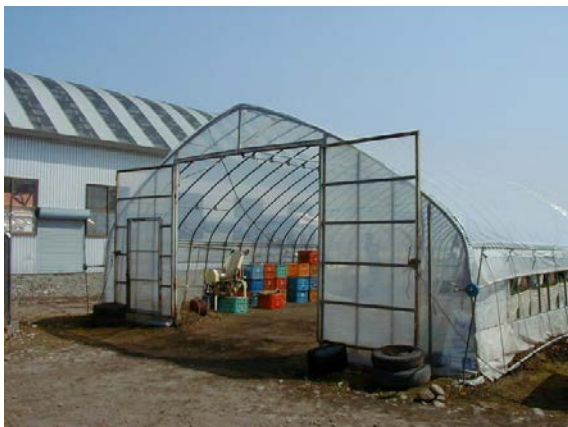
作目：共通 作業：圃場・施設管理 目的：施設整備 方法：機械等が出入しやすいようにハウスの間口を高さ、幅2.5mにし、敷居を除去。
