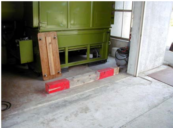
作目： 水稻、穀物 作業： 運搬、乾燥 目的： 作業安全 方法： 舂の張り込み口にトラックが衝突しないように、車止めを設置（□20cmの角材をアンカーボルトで固定）
