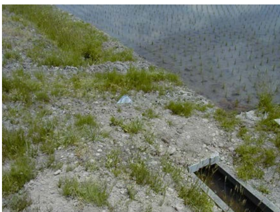
段差を解消した圃場出入口
