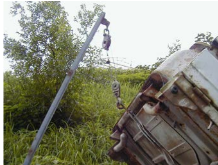
マストと荷台の吊り上げ部
