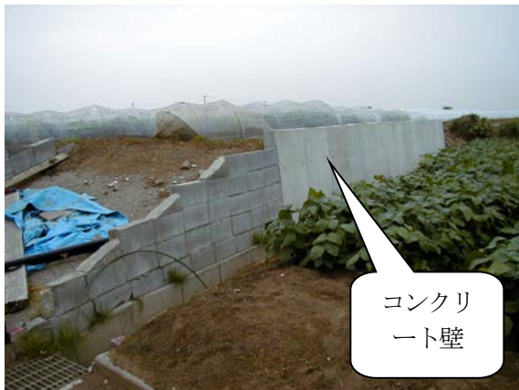
コンクリート壁
