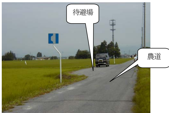
待避場を設置した農道
