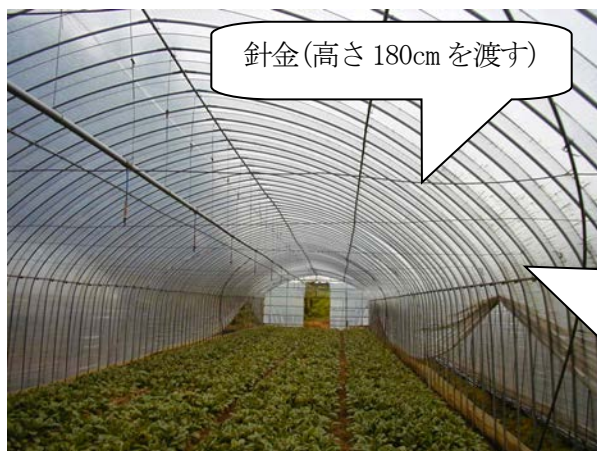
ビニールハウス内部の状態
