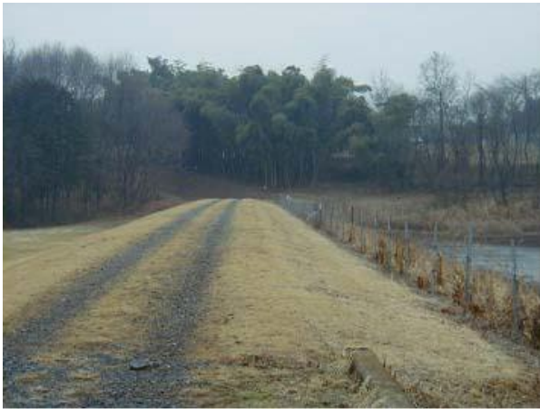
図1 路肩が分かるように、常時草刈りを実施。
