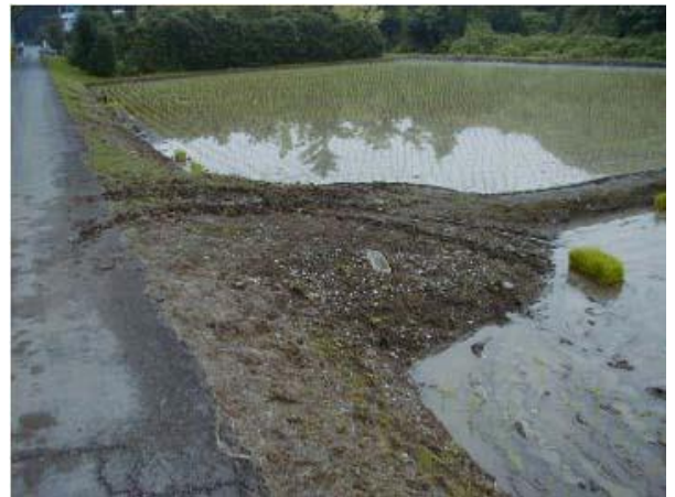
図2 ほ場出入り口の斜面が削れ丸くなっていると車輪が浮きとても危険です。
