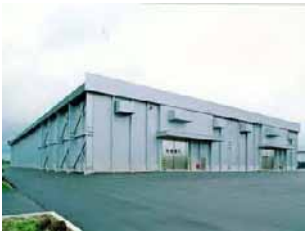
集出荷貯蔵施設
