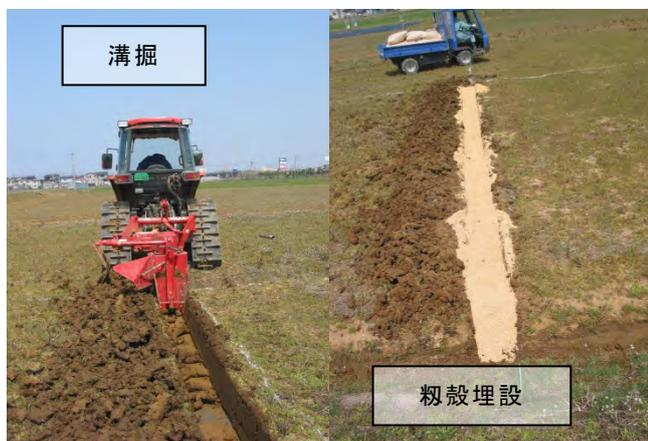
図3 籾殻簡易暗渠の施工状況
