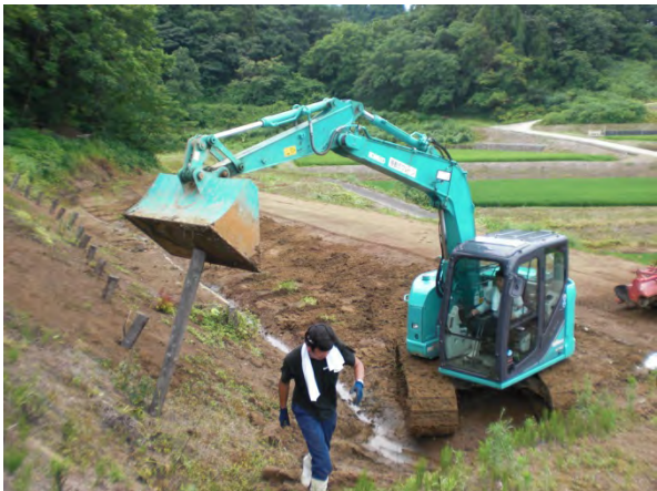
中山間地の地滑り防止工事
