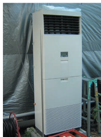
一般店舗用ヒートポンプの例
