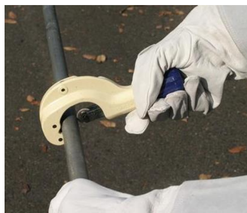
写真3 直管パイプをパイプカッターで切る
