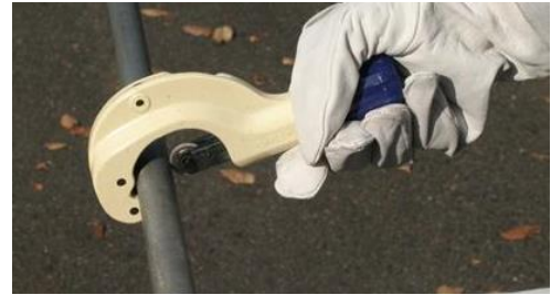
写真4 直管パイプをパイプカッターで切る
