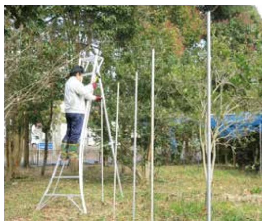
直管パイプを1.5m間隔で樹木列の両側に打ち込む。写真は片側を打ち込んだところ。
