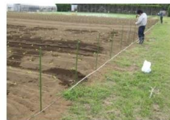
写真2 支柱を打ち込む
