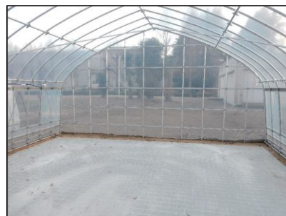
図1 パイプハウスの床面をコンクリート(※)にした場合の内観
