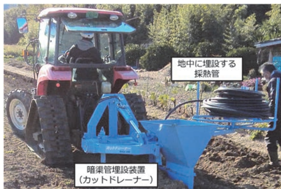
図2 暗渠管理設置装置による採熱管埋設例
