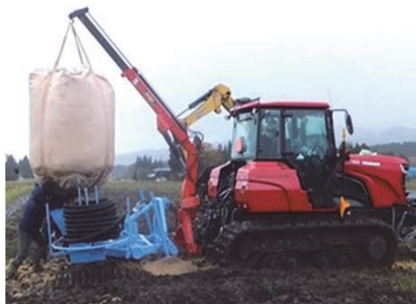
施工時の状況
