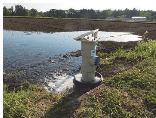
写真1 圃場水管理システムを用いた灌漑
