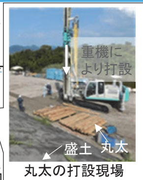
図1 丸太による補強の概略図
