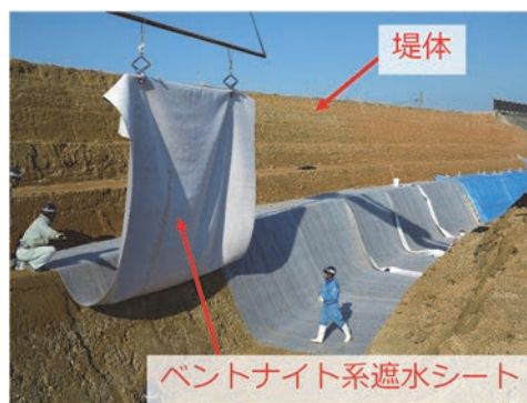
図1 ベントナイト系遮水シートの敷設状況
