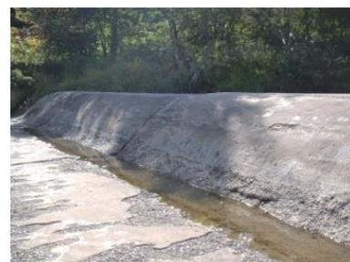
図1 固定堰直下の摩耗の例
