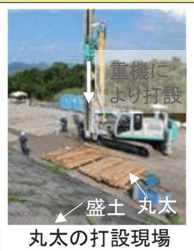
図1 丸太による補強の概略図
