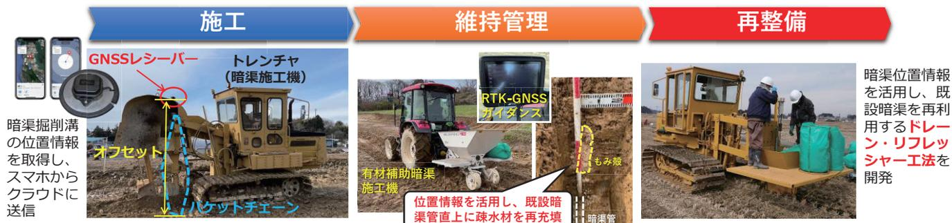
暗渠施工の効率化及び機能の長寿命化、さらに暗渠の再整備コストを半減
