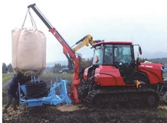
施工時の状況
