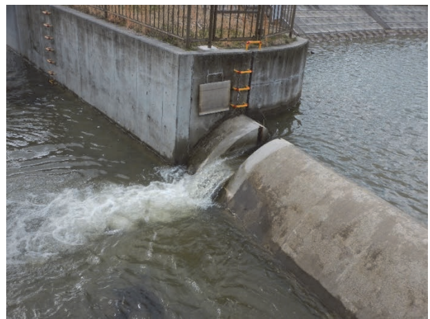
低水位管理を実施しているため池 (洪水吐スリットによる放流)
