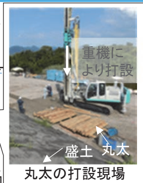
図1 丸太による補強の概略図
