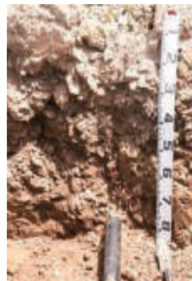
施工後の本暗渠の断面
