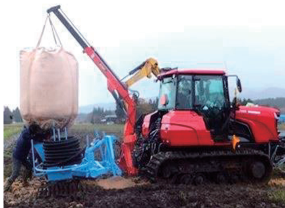
施工時の状況
