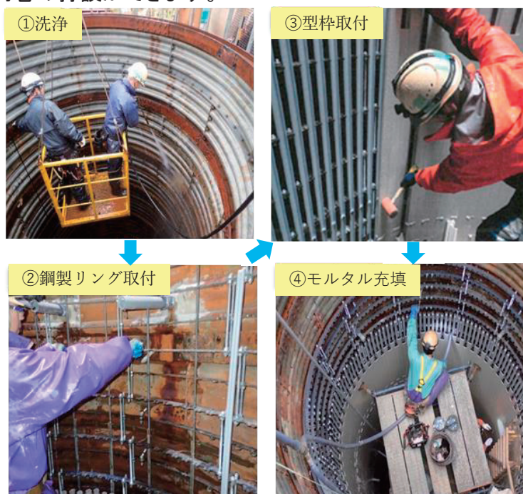
図3 内巻補強工法の施工手順
