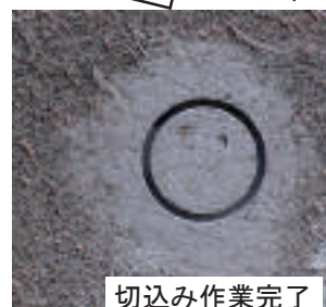
内径45mmのコアドリルで母材まで切込み(1~2分程度)
