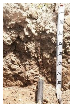
施工後の本暗渠の断面
