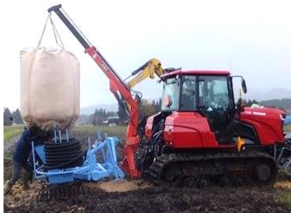
施工時の状況
