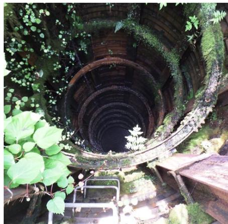
図1 老朽化が進む集水井
