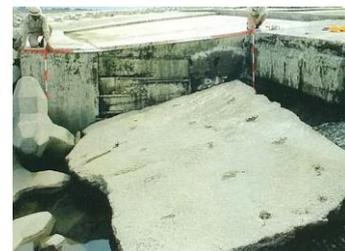
堰の被災事例(エプロン陥没)
