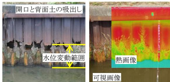
図1 鋼矢板の腐食状況 図2 鋼矢板の熱画像例
