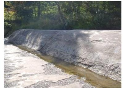
図1 固定堰直下の摩耗の例
