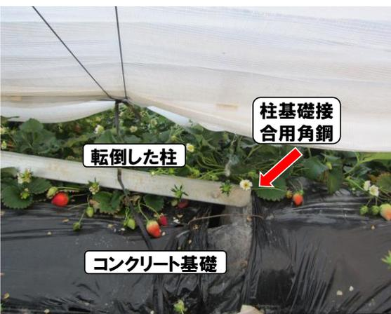
柱基礎接合部の破壊が顕著でした。
