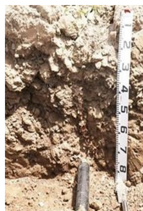
施工後の本暗渠の断面
