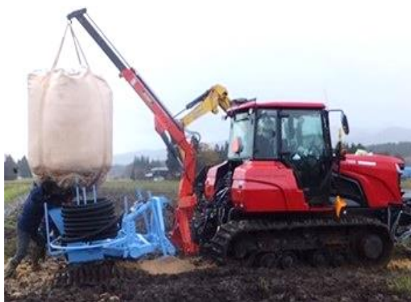
施工時の状況
