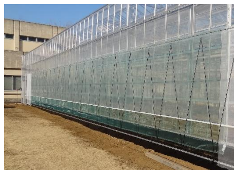
園芸用施設に施工された新防虫ネットの実施例
