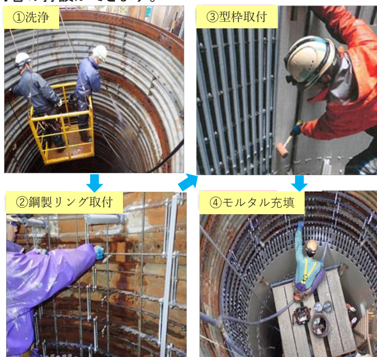
図3 内巻き補強工法の施工手順
