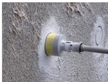
内径45mmのコアドリルで母材まで切込み(1~2分程度)
