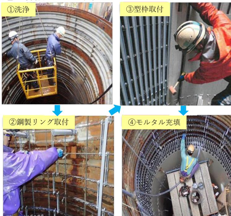
図3 内巻き補強工法の施工手順
