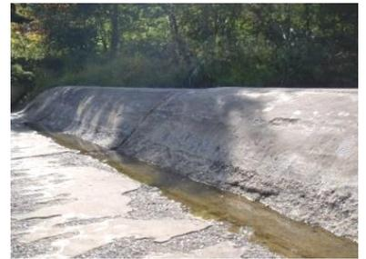
図1 固定堰直下の摩耗の例
