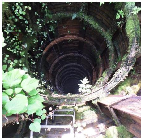
図1 老朽化が進む集水井
