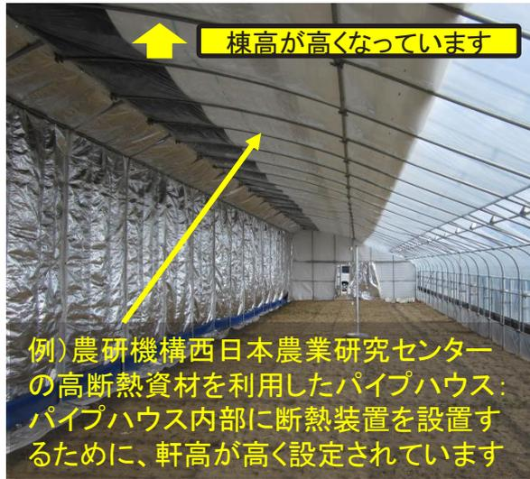
パイプハウスの軒高が高くなると、周辺気流が変化し、パイプハウスに作用する風圧力分布が影響を受ける可能性があります。
